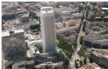
RÉNOVATION TOUR PLEYEL, SAINT-DENIS
