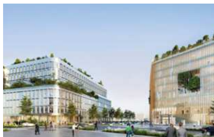
IMMEUBLES DE BUREAUX V2 ET V3 DOCK EN SEINE, SAINT-OUEN
