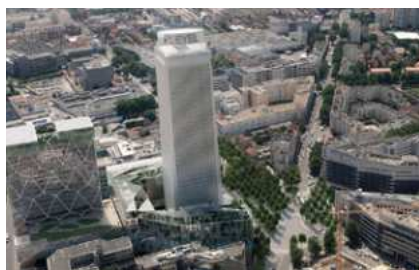
RÉNOVATION TOUR PLEYEL, SAINT-DENIS
