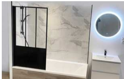
RÉNOVATION SALLE DE BAIN PARTICULIER, SEB LE PLOMBIER
