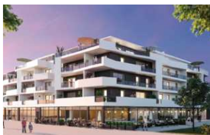
IMMEUBLE HEXAGONE, BEZZANNES
