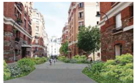
RÉHABILITATION DE 469 LOGEMENTS, RUE MARCADET, PARIS
